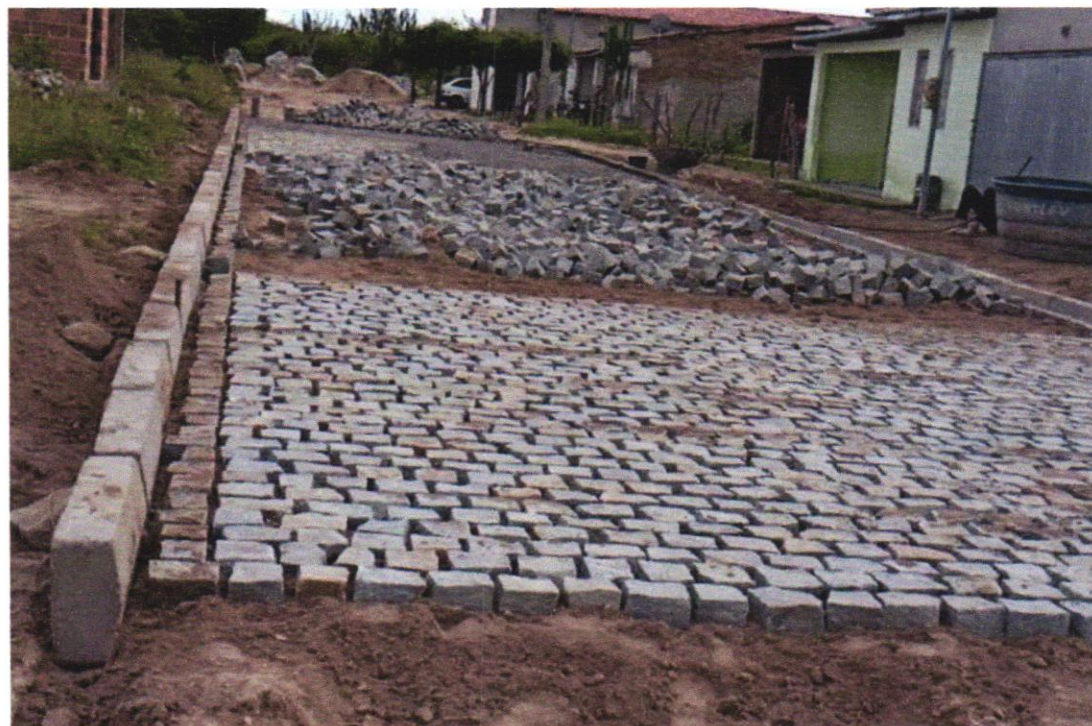
(FOTO 04) EXECUÇÃO DE PAVIMENTAÇÃO E MEIO FIO
