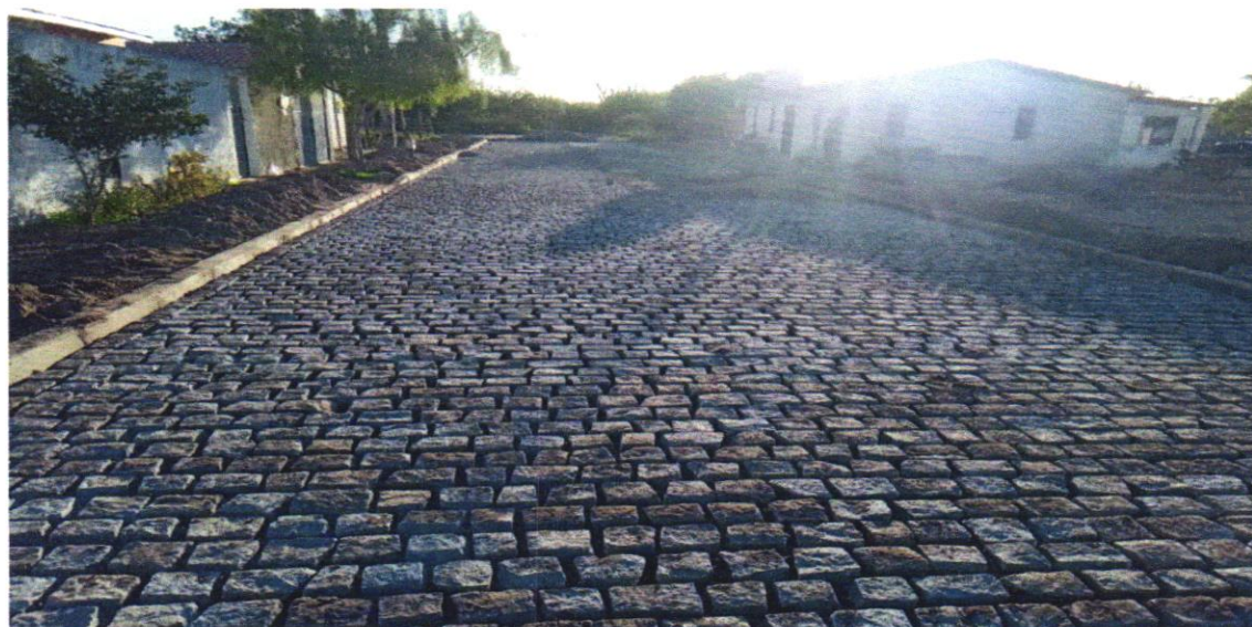
(FOTO 08) EXECUÇÃO DE PAVIMENTAÇÃO E MEIO FIO
