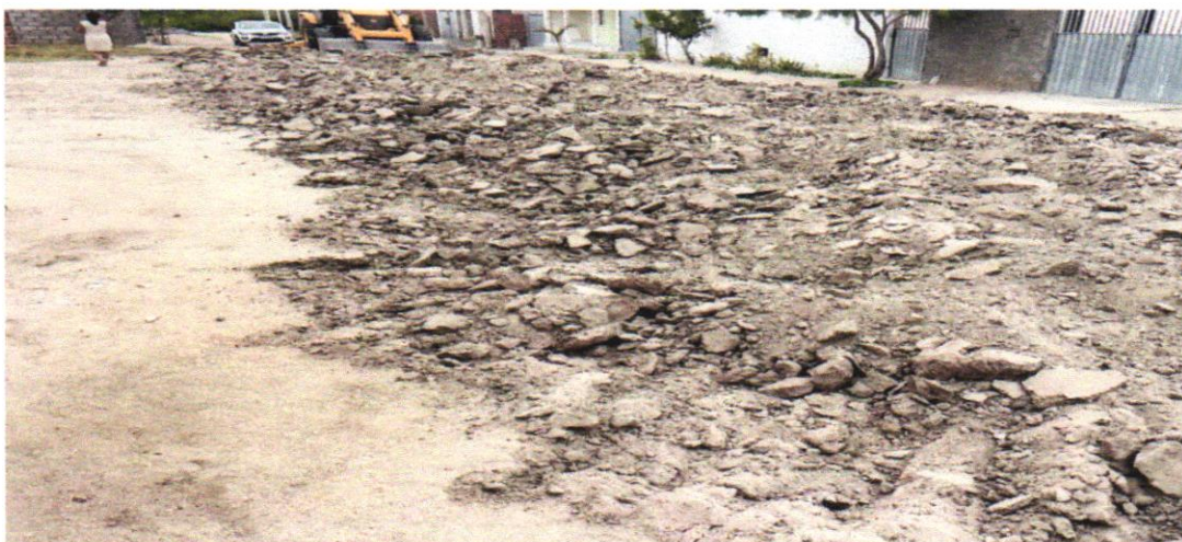
FOTO 01 REGULARIZAÇÃO E COMPACTAÇÃO
