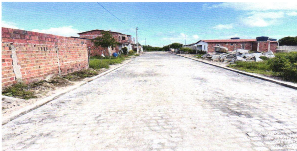
(FOTO 07) EXECUÇÃO DE PAVIMENTAÇÃO E MEIO FIO
