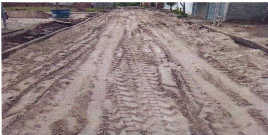
FOTO 02 REGULARIZAÇÃO E COMPACTAÇÃO
