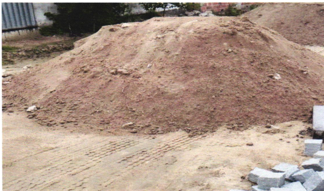
(FOTO 03) AREIA PARA COMPACTAÇÃO DO LEITO
