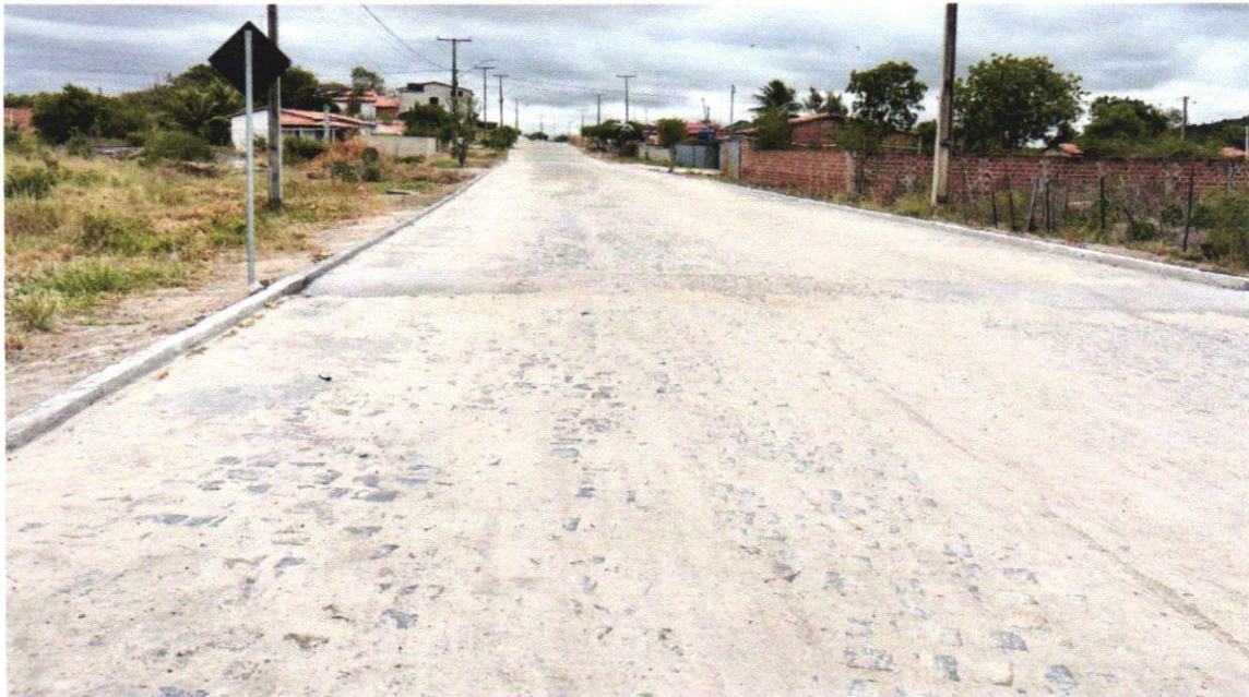
(FOTO 05) EXECUÇÃO DE PAVIMENTAÇÃO E MEIO FIO
