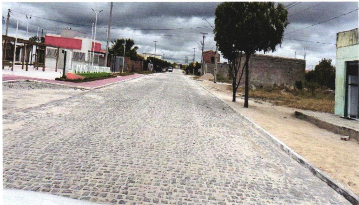
(FOTO 06) EXECUÇÃO DE PAVIMENTAÇÃO E MEIO FIO
